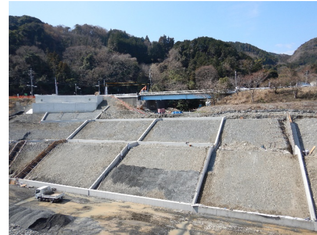
護岸付属物工（横帯工）
