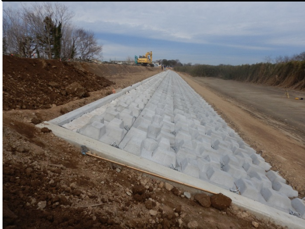
コンクリートブロック工 （コンクリートブロック張）
