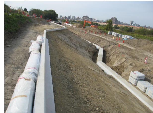
基礎工（護岸） （プレキャスト）
