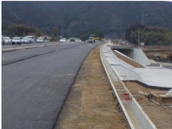
側溝工（U型側溝）
