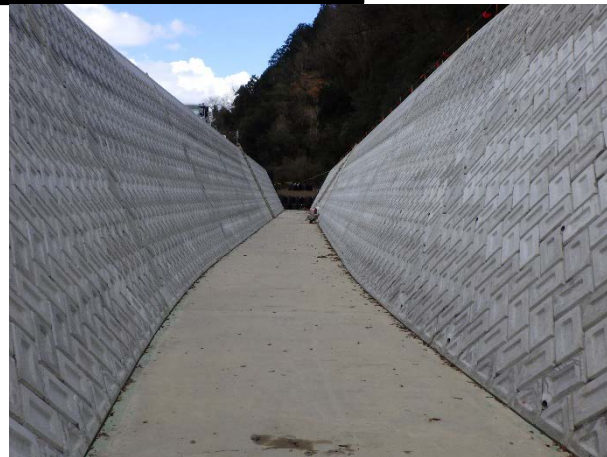
コンクリートブロック工 （コンクリートブロック積）
