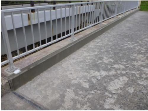
写真-3 ハイブリッドエポキシ樹脂による断面修復完了状況
