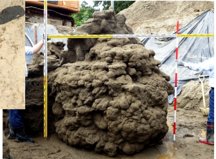
計画改良体径 \phi 1800 14L/min
