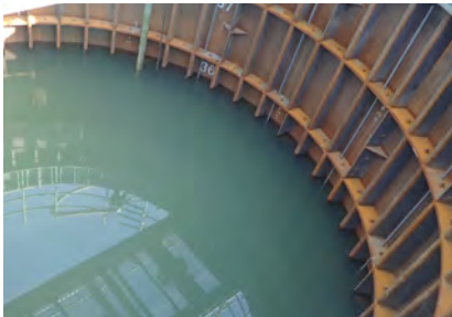
水中掘削時のシールド立坑
