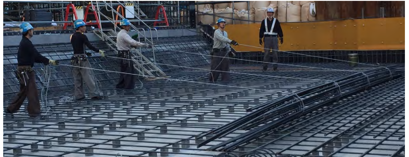
重い配筋（D32）の展開・配筋状況
