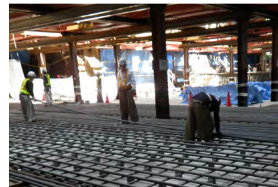
鉄筋間隔調整 (長時間中腰姿勢)
