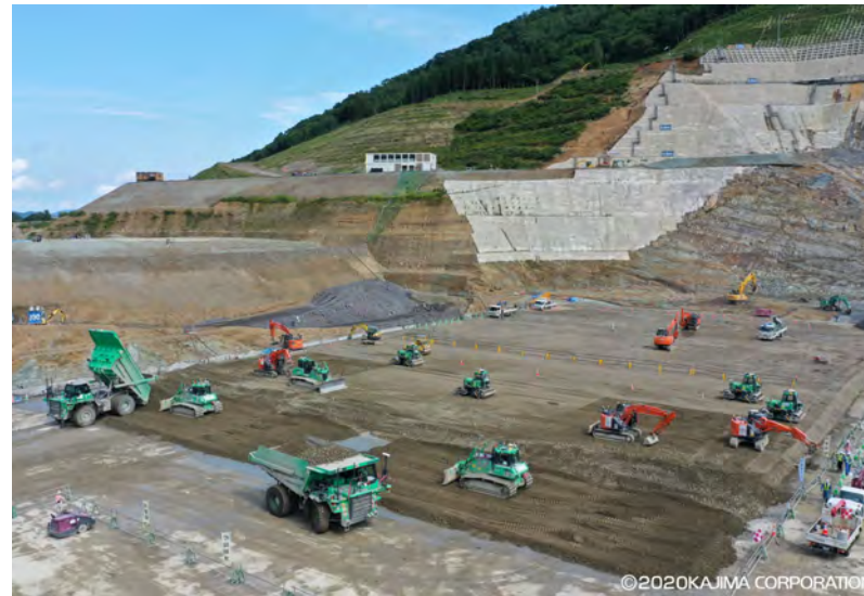
管制室からの指示で複数の重機が連携して作業を行う
