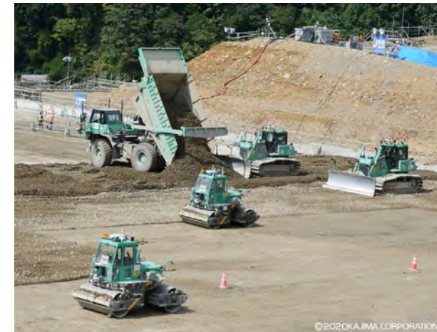
管制室からの指示で複数の重機が連携して作業を行う
