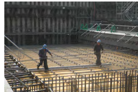
鉄筋小運搬・間配り (1本ずつの運搬)
