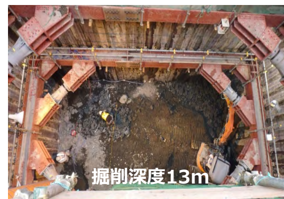
掘削工事への適用状況
