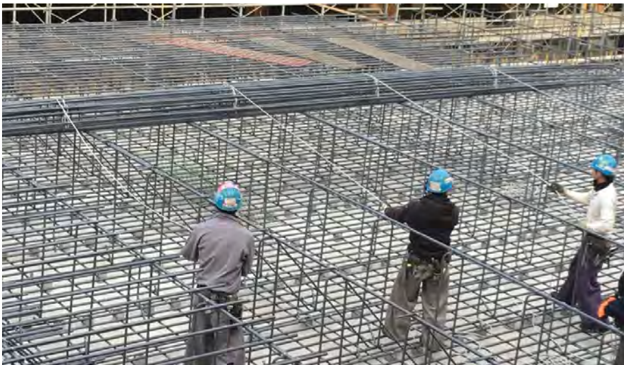
上筋の展開・配筋状況
