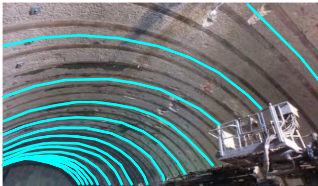
支保への光ファイバ設置概要
