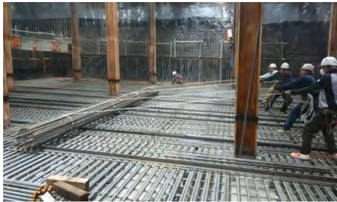
底版の下筋での 引張展開式工法の施工状況
