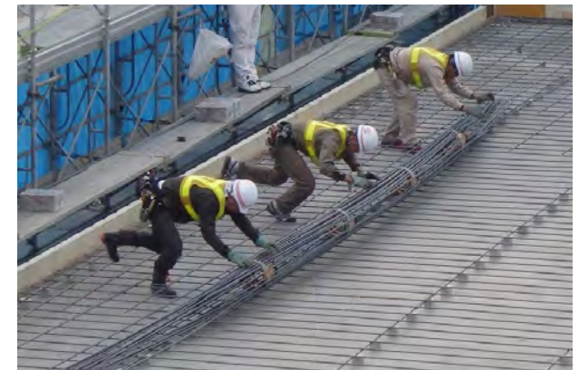
現場にてロールマットを 絨毯を広げる様にして配筋
