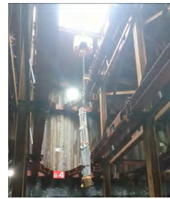
開口部から縦吊り での投入状況
