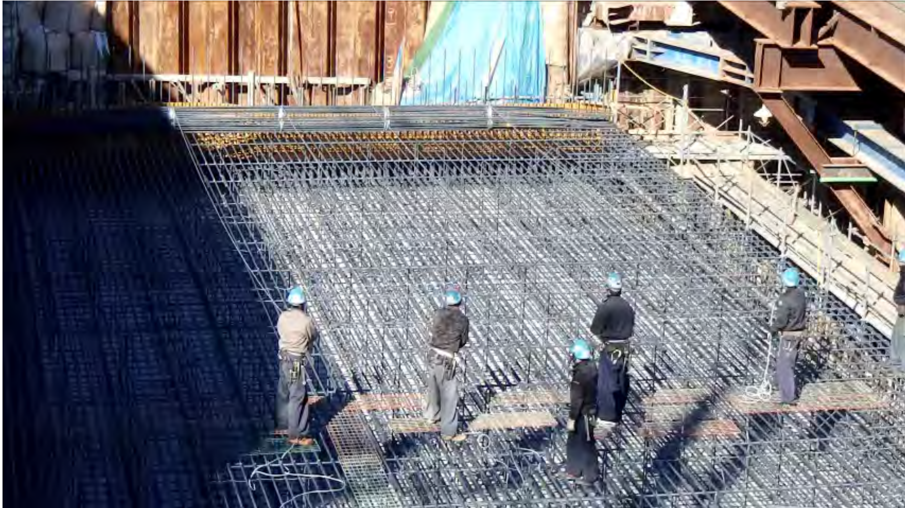
重い配筋（D32）の展開・配筋状況
