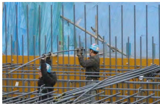
鉄筋小運搬・間配り (上筋の場合、更に負担増)
