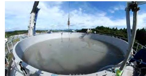
水中掘削によりは内部は濁水状態
