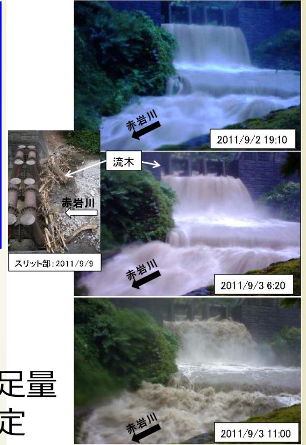
➡ 砂防堰堤での流木補足量から流木流出率を算定
