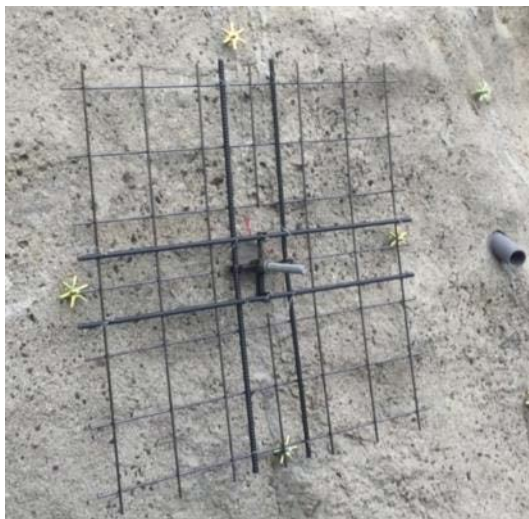
補強部材取付
