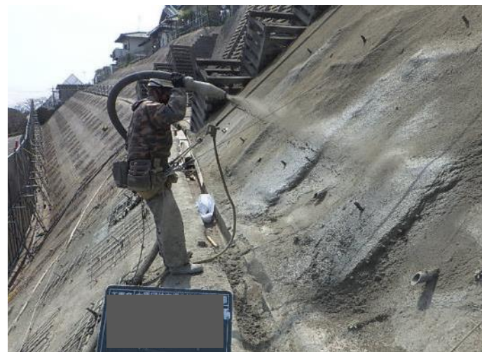
繊維補強モルタル吹付
