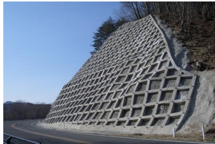
対策後ののり面
