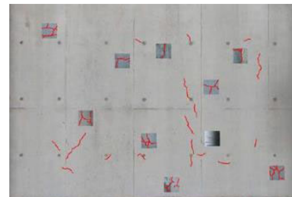
展開画像を元に損傷図トレース 位置把握が容易
