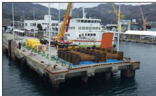
図-15 松山市中島港フェリー岸壁
