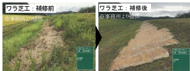
図-6 イノシシ掘起し箇所の補修例（わら芝工）
