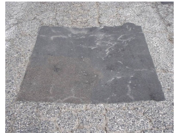
物流センター：施工2年後
