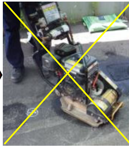
転圧機械 転圧作業不要
