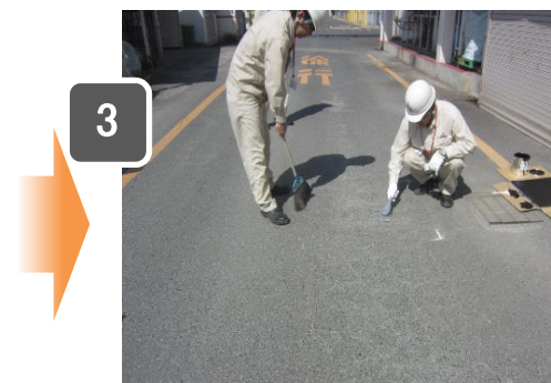
既設路面の清掃
