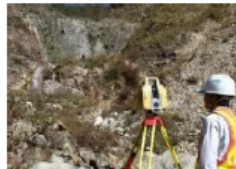
清掃後の法面をTLS・ UAVにより遠隔測量
