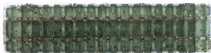
栈橋の点検写真（3Dモデル）
