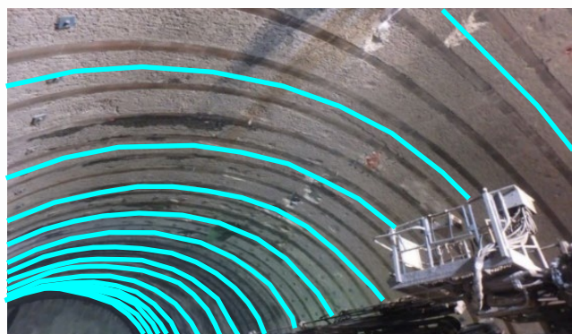
支保への光ファイバ設置概要
