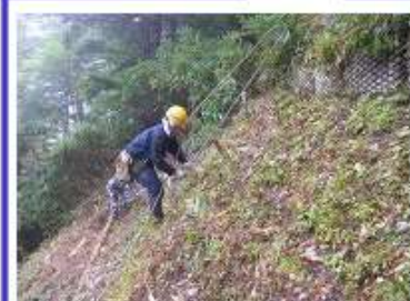
斜面上の測量作業
