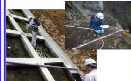
高所斜面上の臨場検査
