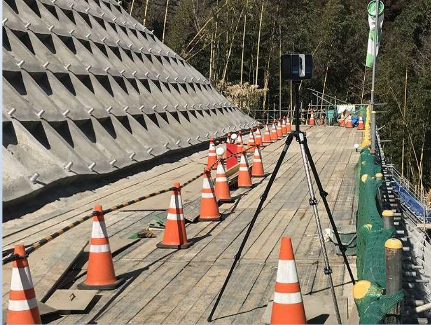
地上型レーザースキャナ FARO S350使用
