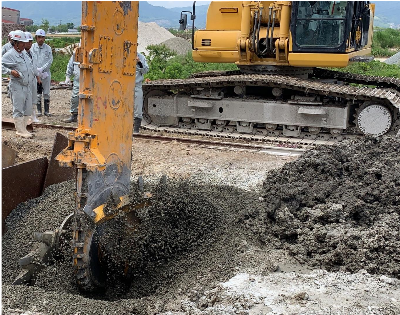
WILL工法による造成方法（試験施工）
