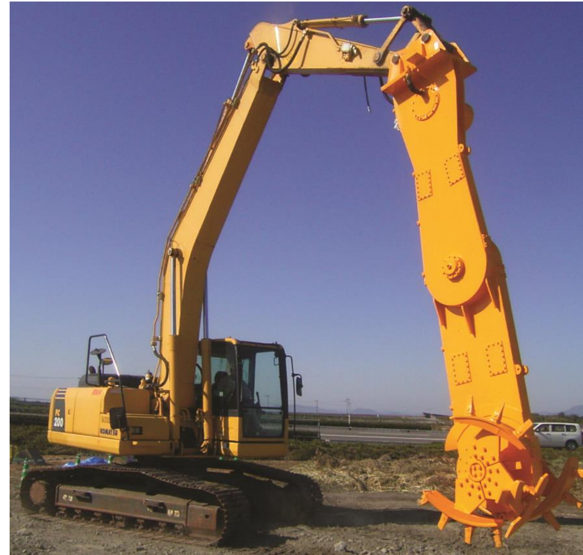
WILL工法施工機械全景
