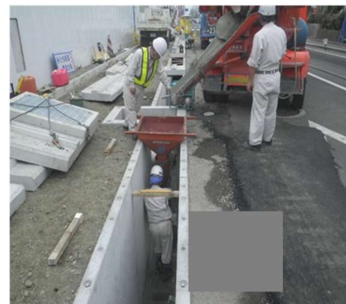
⑤インバートコンクリート打設
