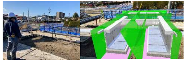
図-6 GNSS測量とMR技術による現地と3次元設計モデル
