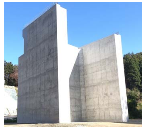
写真-4 橋台完成(背面)
