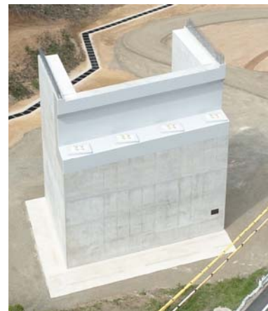
写真-3 橋台完成(前面)
