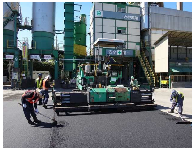
写真-3 試験施工状況
