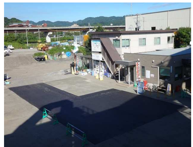
写真-4 試験施工箇所全景
