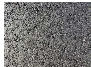
写真-6 施工直後の路面状況
