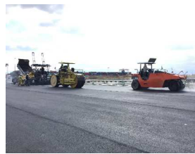
写真-5 施工状況
