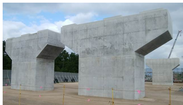
写真- 1. 第2工事 完成写真
