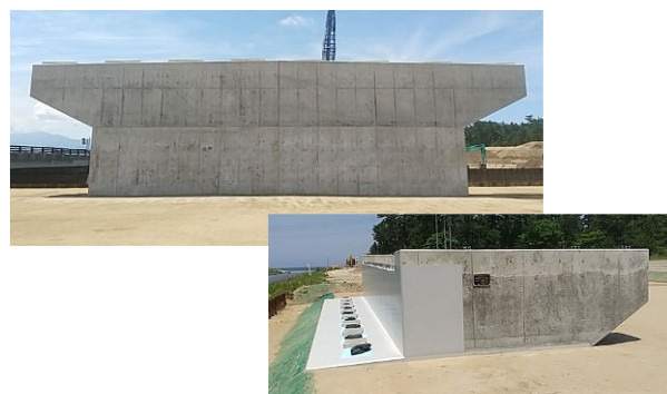
写真- 2. 第9工事 完成写真
