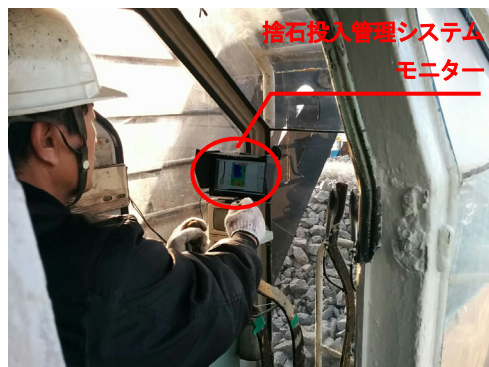
写真-2 捨石投入管理システム使用状況
