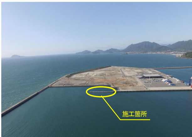
写真-1 施工箇所（完成全景）
