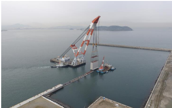
写真-3 ケーソン据付状況
