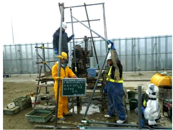
写真-4 測定管の建て込み状況 (A-87)
