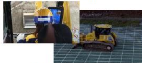
ICT建機による施工
