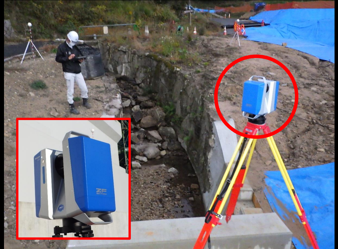
TLS(地上型レーザースキャナー) による現場計測状況
