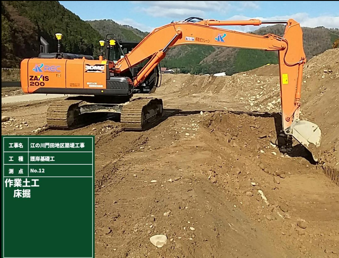
作業土工状況(護岸基礎)
