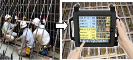
システムによる撮影で鉄筋間隔、鉄筋径の確認が可能
