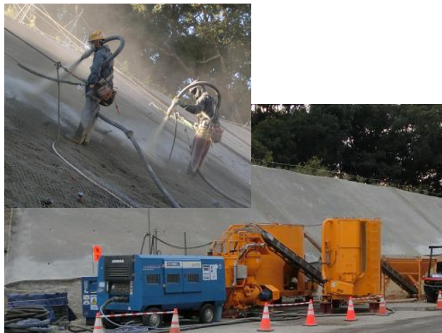
写真-8 2本ノズル吹付の全自動運転状況
