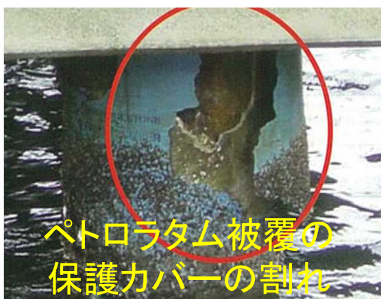
モルタル被覆のカバー材 およびモルタルの脱落
