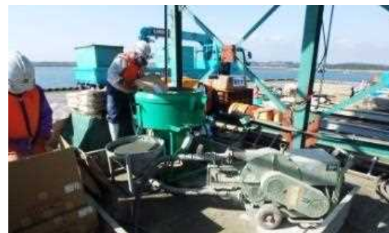
繊維補強モルタル製造 (栈橋上)
