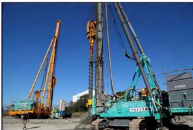
写真-1 深層混合処理工 全景 (RASコラム工法)
