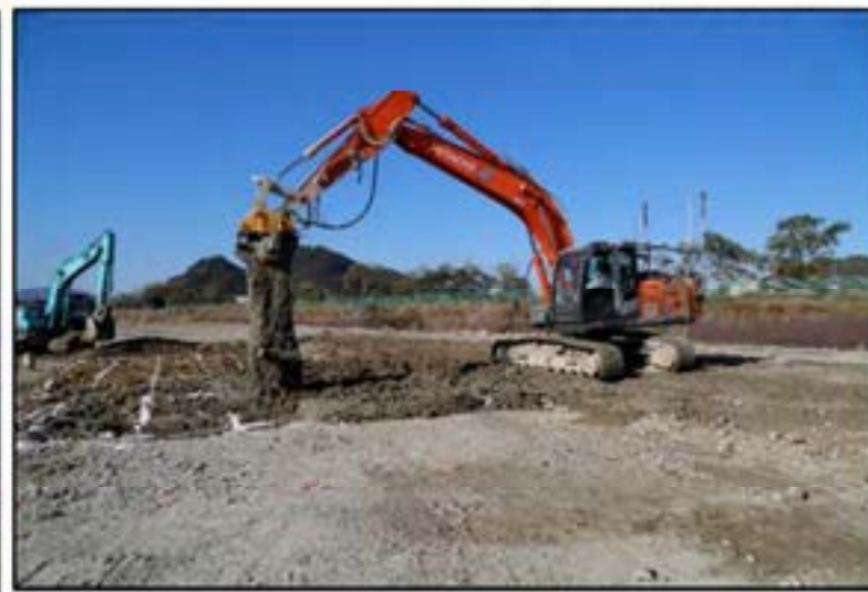
写真-2 中層混合処理工 全景 (SCM工法)
