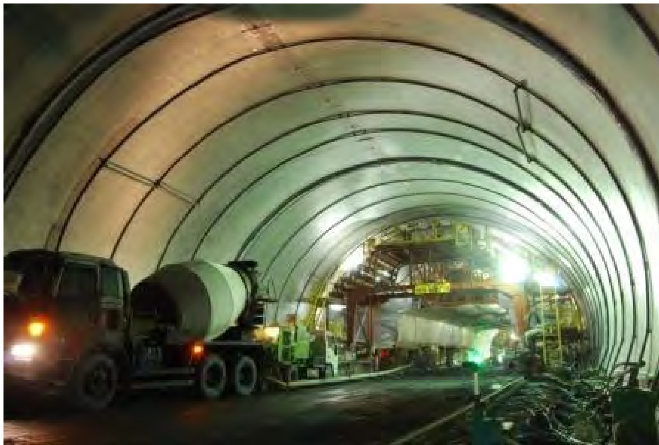
アクアカーテン施工状況
