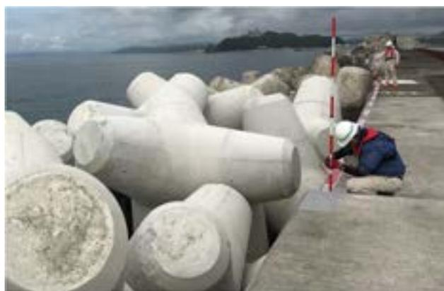
図-1 消波ブロックの出来形計測状況
