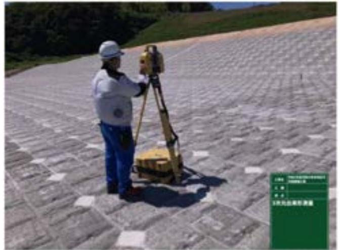
写真-12 大型ブロック3次元出来形測量の実施
