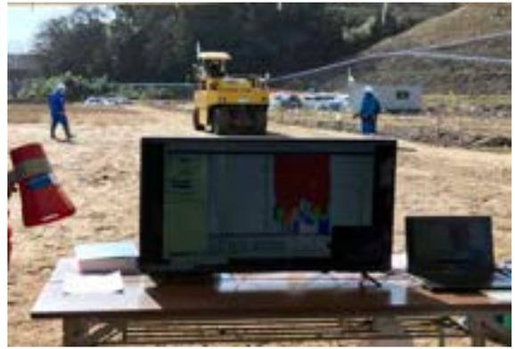
写真-11 SiteCompactorによる転圧管理
