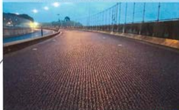
国道9号布志名地区外舗装修繕工事
