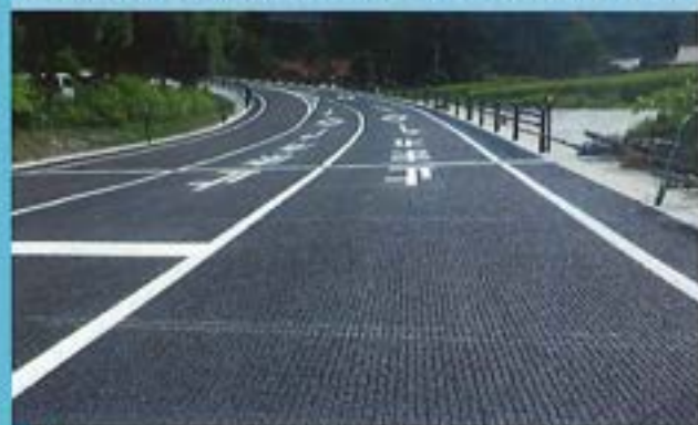
柿木津和野停車場線(中座工区)(舗装)工事(第9期・第10期)
