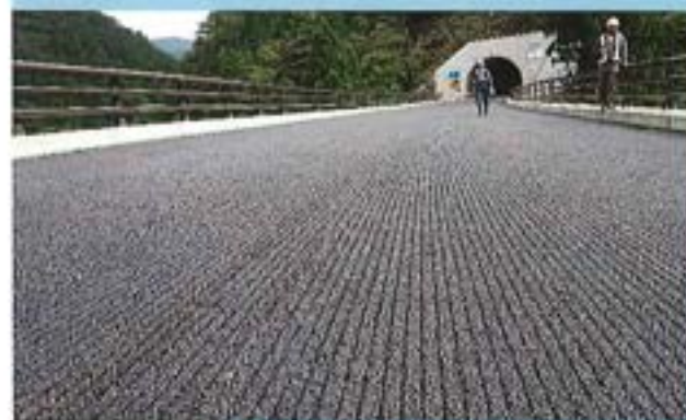
国道482号(春米バイパス)舗装工事
