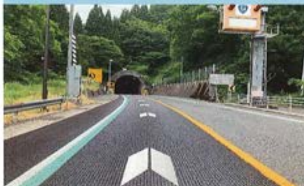
令和2年度頃原維持出張所管内舗装修繕第2工事
