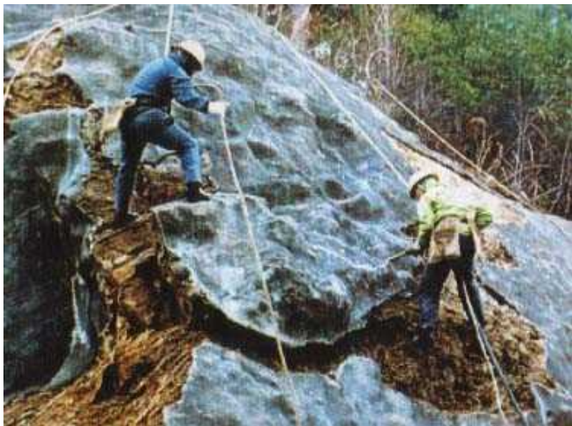
取り壊し状況
