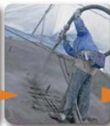
繊維補強モルタル吹付
