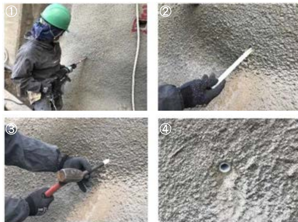
MDLパイプの施工手順
