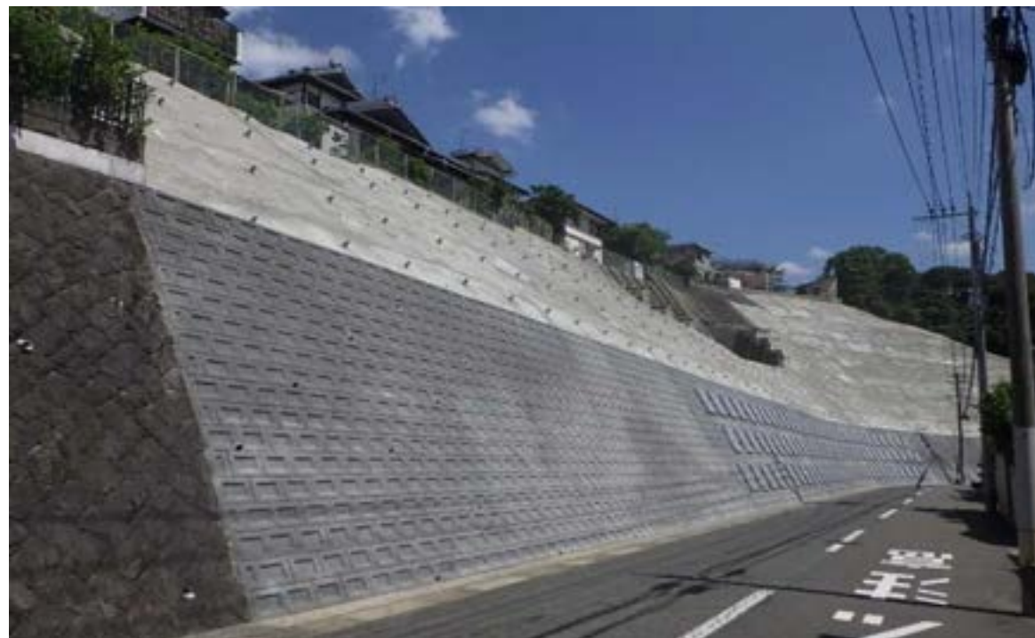
施工完了後 全景
