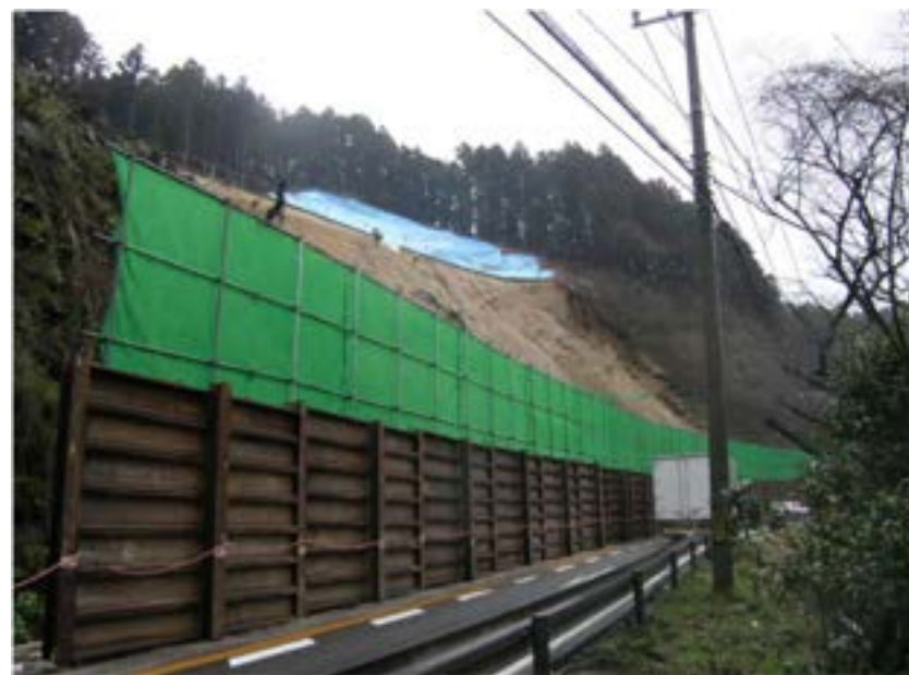
仮設防護柵設置(例)
