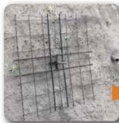
補強部材設置
