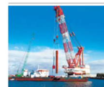
テーパー杭打設の様子
