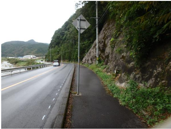
写真-3 法面更新工事の作業環境
