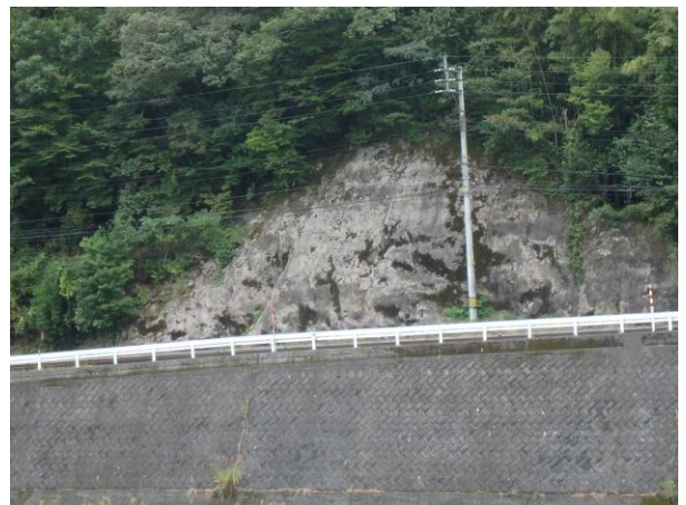
写真-2 法面更新工事の現場写真
