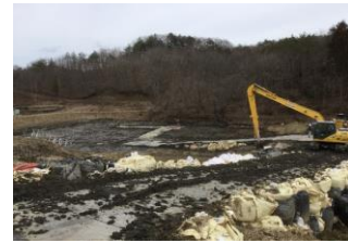
写真-8 仮設道路施工状況
