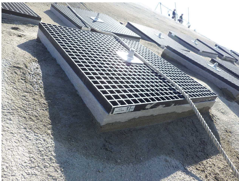
モルタル台座・不陸調整マットなどによる調整
