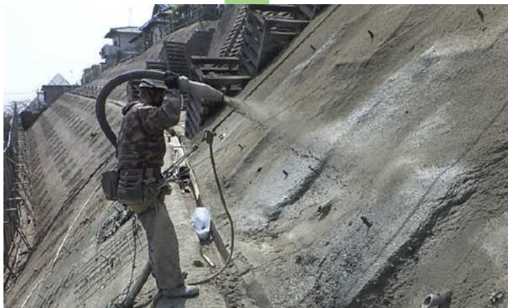
FSCパネル 吹付状況
