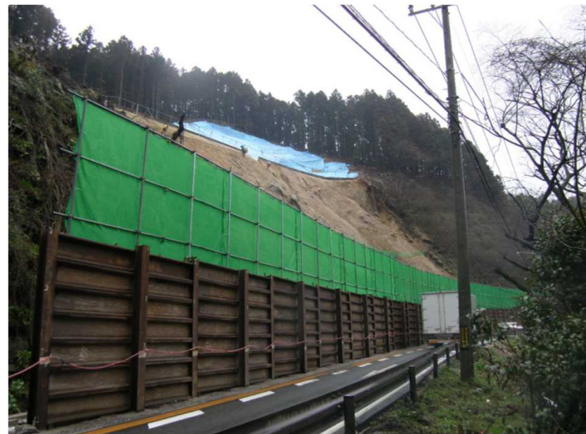
仮設防護柵設置(例)
