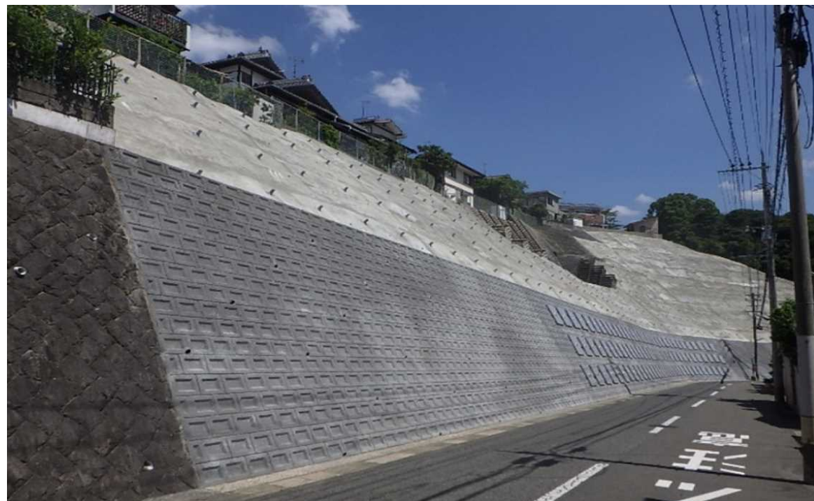
施工完了後 全景
