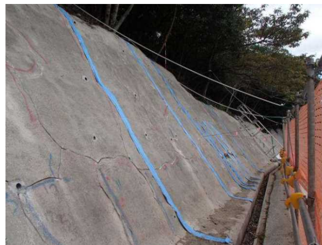
湧水処理工の例
