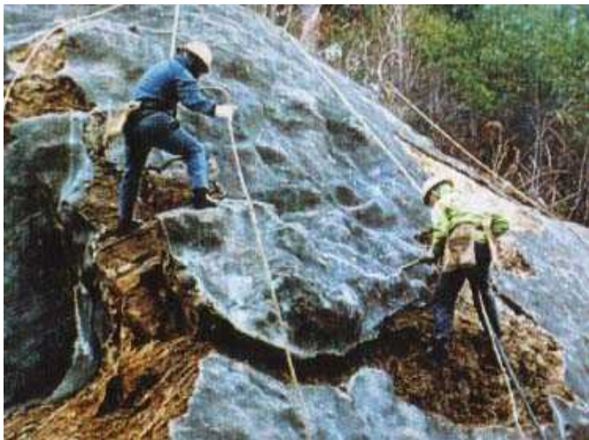
取り壊し状況
