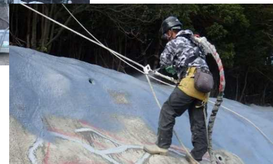
防水材吹付の状況
