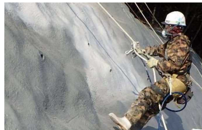
仕上げ材吹付の状況
