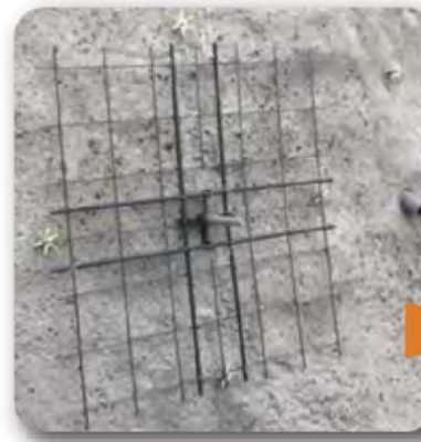
補強部材設置
