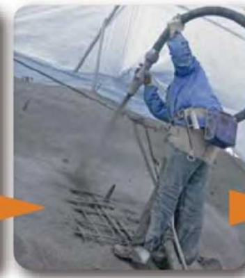
繊維補強モルタル吹付
