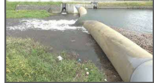
放水路 分水堰
