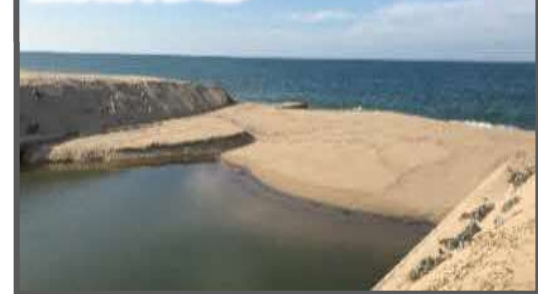
放水路 河口部
