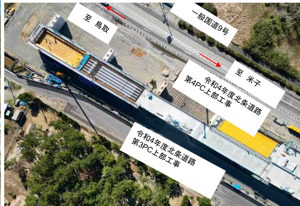
架設状況 2023年2月撮影
