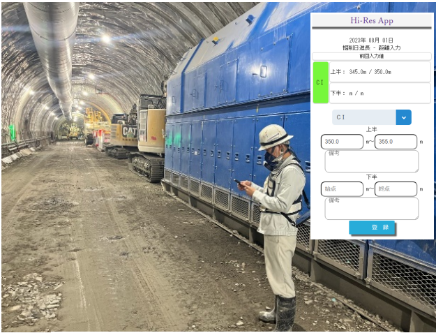
写真-1 スマートフォンによる進捗管理
