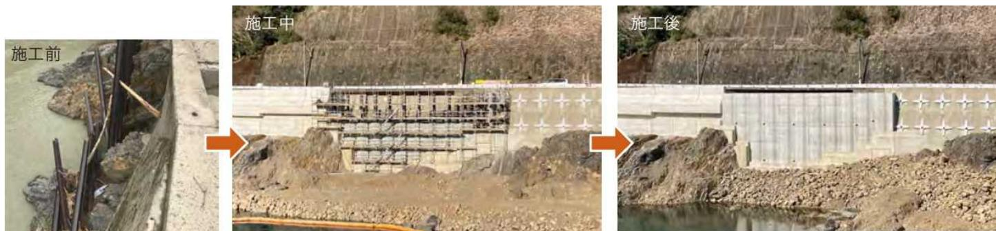
2020年7月初旬に発生した球磨川の洪水で、過去に施工していた親杭パネル壁工法が護岸を保護していたことから、広く、他区間の護岸復旧に採用
