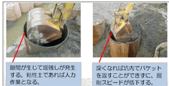
写真-5 通常のパケットによる杭頭部掘削状況
