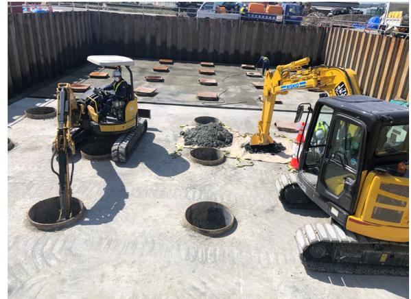
写真-7 下部工事でのMQバケットの利用状況
