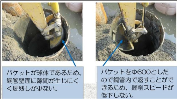
写真-6 MQバケットによる杭頭部掘削状況
