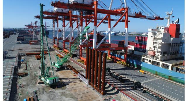
写真-4 名古屋港飛島ふ頭改良工事鋼管矢板打設状況
