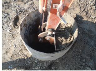
写真-3 杭頭部掘削拡大
