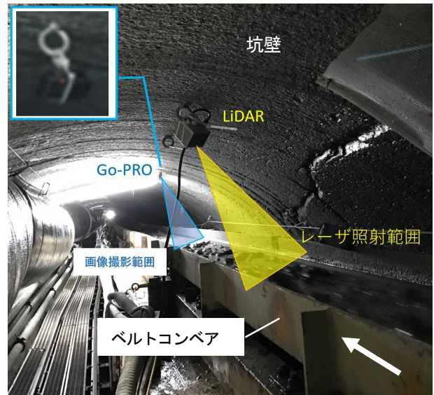
図-5 LiDARによる掘削ズリ形状計測状況
