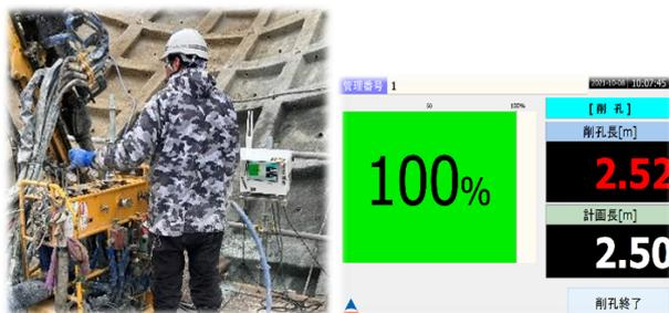
写真-4 ICT削孔管理システムの施工状況
