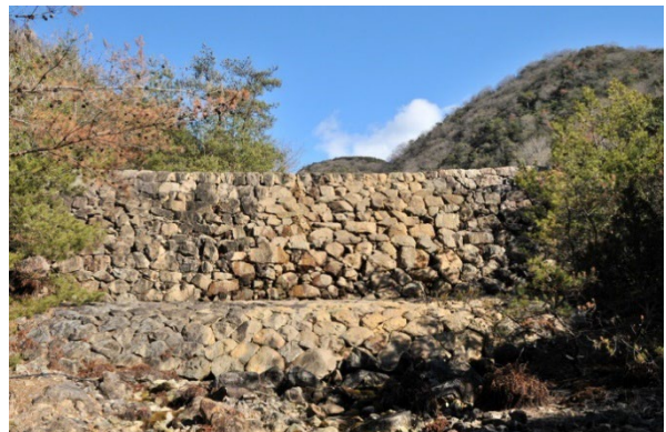
写真-3 矢掛町横谷の2段になった砂防堰堤
