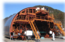
吹付け機 Tunnel RemOS -Spray 筑穂トンネル 2022.9終了
