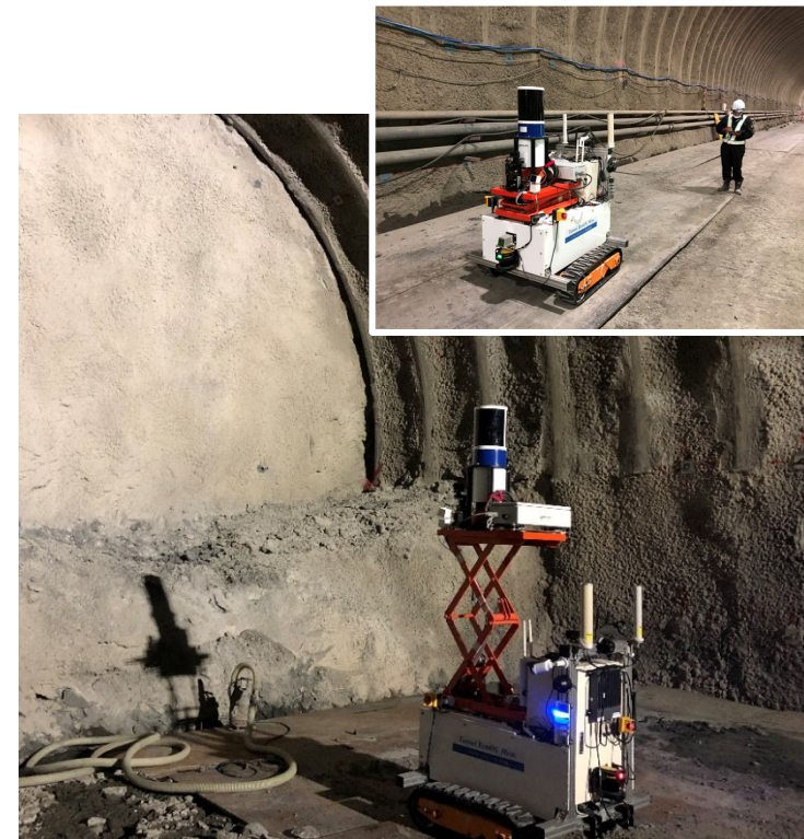
開発システム試行状況（磐石トンネル）
