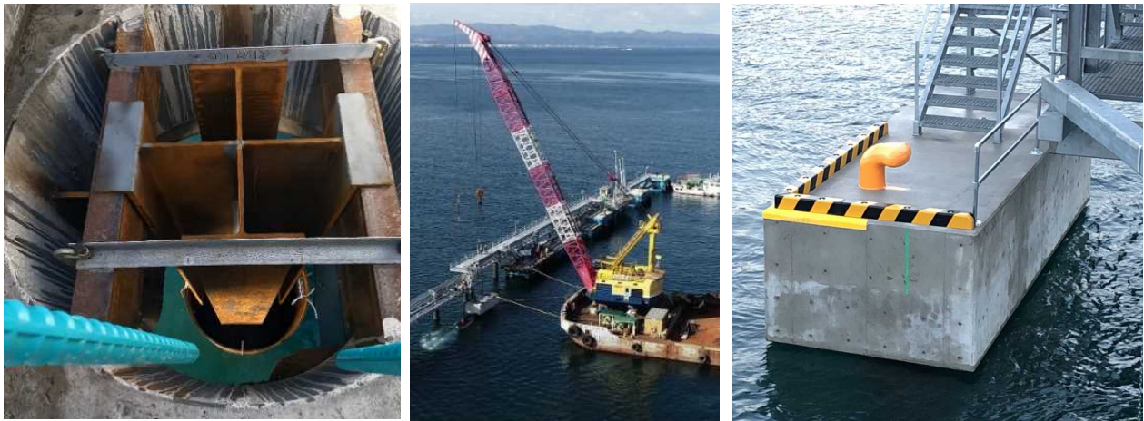
図-9 本工法の適用事例（施工状況と完成状況）
