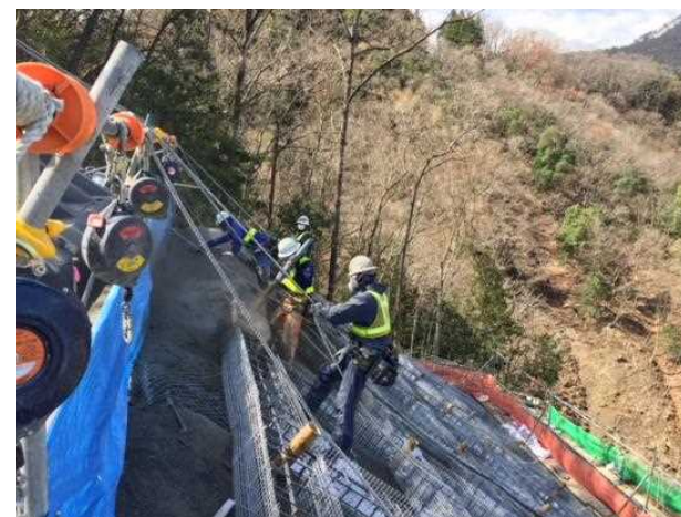
複数人体制の法面作業 (ノズルマンは 特に重労働 )
