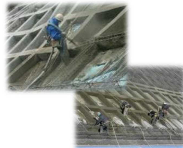
②モルタル吹付、吹付枠整形
