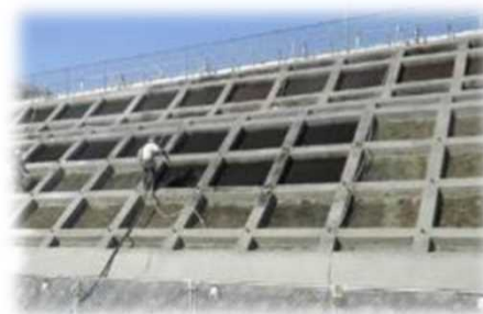
③枠内吹付
