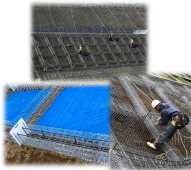
①型枠・鉄筋組立
