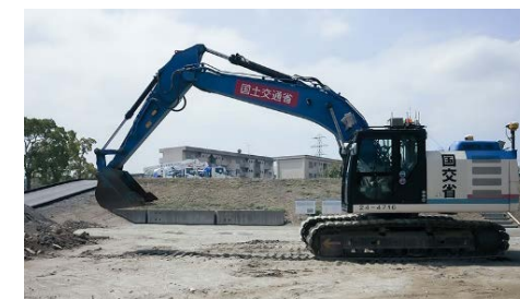
③遠隔操縦(無人化)施工
