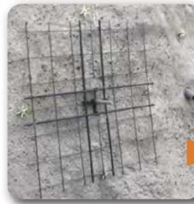
補強部材設置
