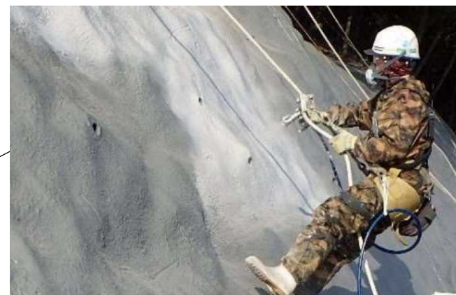
仕上げ材吹付の状況
