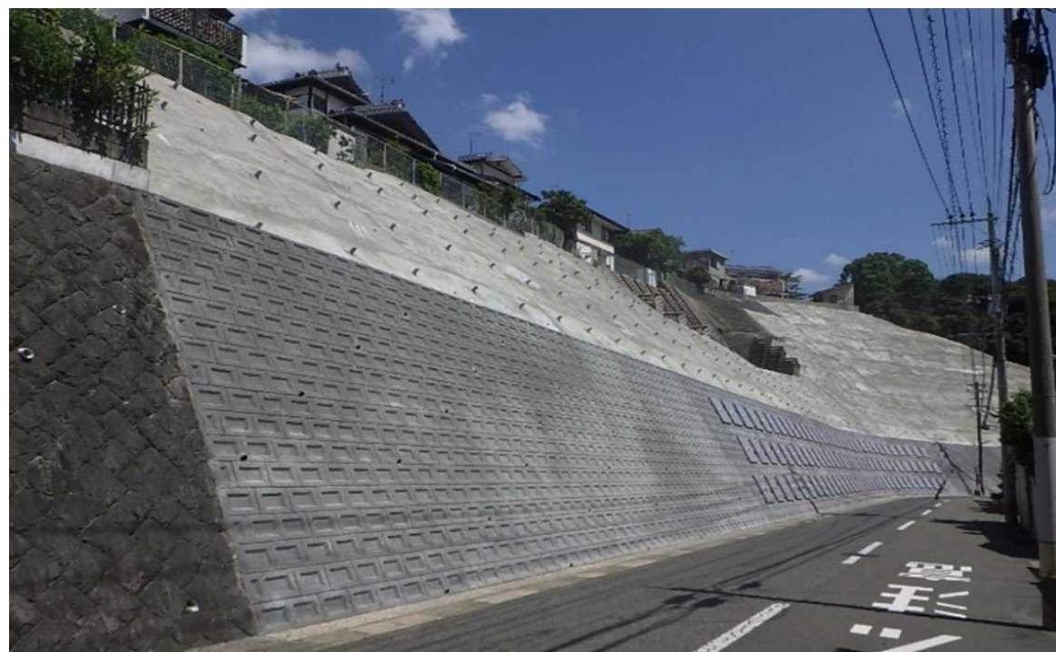
施工完了後 全景
