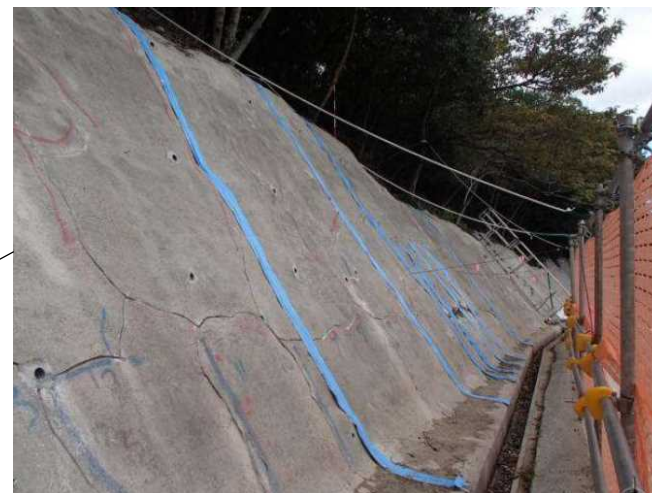
湧水処理工の例
