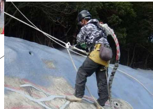
防水材吹付の状況
