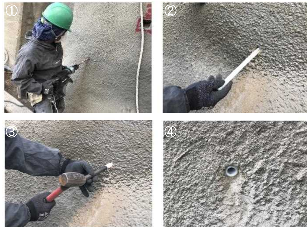
MDLパイプの施工手順
