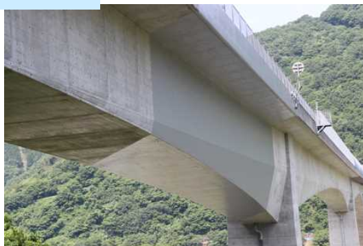
既設橋梁の保護
