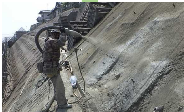
FSCパネル 吹付状況
