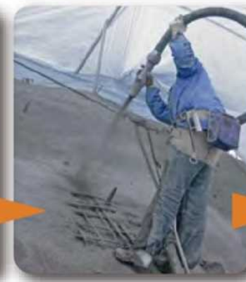
繊維補強モルタル吹付
