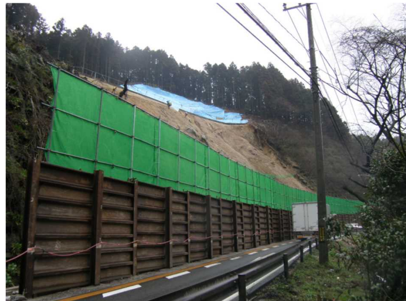
仮設防護柵設置(例)
