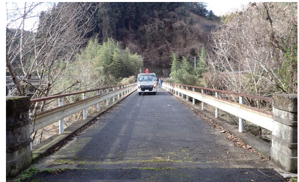
図-8 小郷橋（鋼橋，A市）
